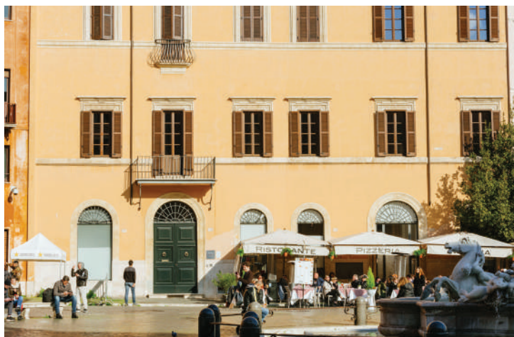
Façade de l'immeuble place Navone (EFR/Ch. Mantuano)
