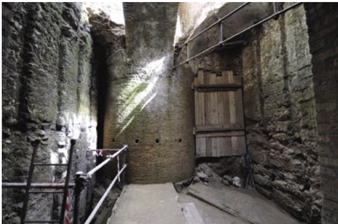
Fig. 7: Palatin - Vue du pilier central et des arcs qui s'en détachent au sommet de la construction et au niveau du 1 er étage.
