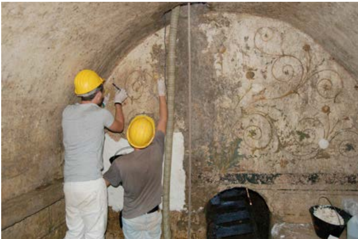
Fig. 3 - Cumes. Travaux de restaurations des enduits peints du Mausolée d'époque tibérienne D50 : Cliché S. D'Onofrio, CJB).
